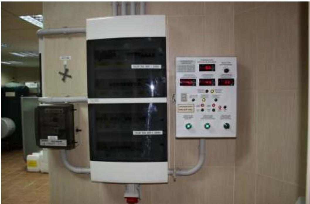
**Sala de máquinas. Delante: 3 de los 8 cuadros de mando. Izquierda a derecha: cuadro del pozo, cuadro principal de sala de máquinas y cuadro del autómata solar. Todos los mecanismos tienen calificación de primera marca (Schneider Electric®).**
