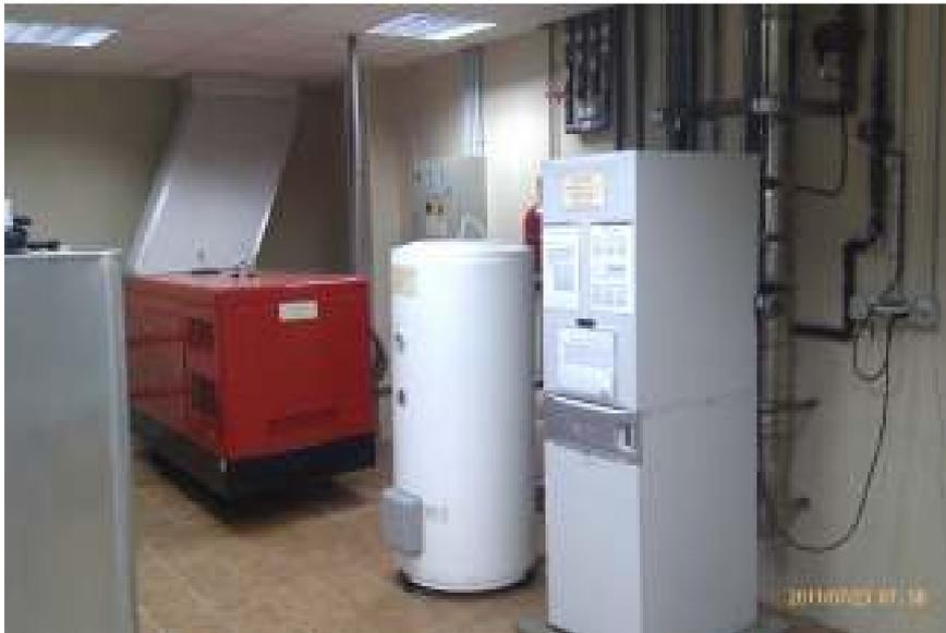
**Sala de máquinas. Delante: caldera e intercambiador solar para agua potable, chimenea de evacuación de humos, sonda de temperatura, conducciones y valvulería. Detrás (no visible), circulador de paneles solares para calefacción y tanques de expansión. Fondo: generador trifásico aislado (30KVA), evacuación de humos de y panel de control automático.**
