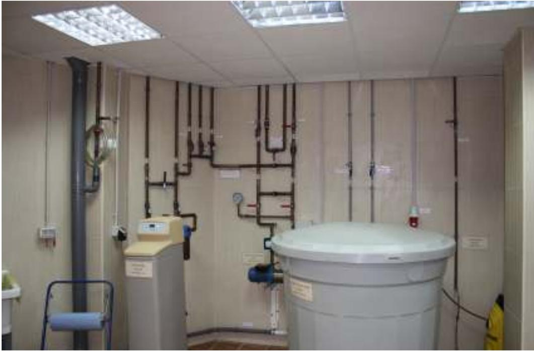
**Sala de máquinas. Área principal de suministro de agua potable, mostrando tanque de almacenamiento (1 Ton), descalcificador (salmuera seca), bomba impulsora con estabilizador de presión, tuberías y válvulas para aprovechamiento y distribución del agua de pozo.**
