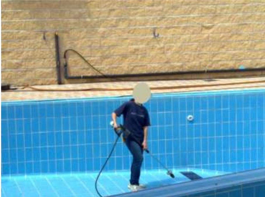
*Tareas de mantenimiento previas a temporada de baño. Piscina de juegos vacía. Limpieza mediante hidrolimpiadora Karcher conectada al circuito exterior (en superficie).*
