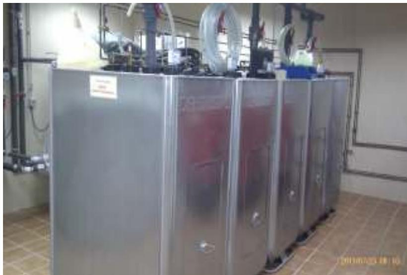
**Sala de máquinas. Delante: tanques de gasoil de doble cubeta (Dehoust ®), capacidad total hasta 5.000 litros. Fondo derecha: alimentación de gasoil para el grupo trifásico y la caldera. Fondo izquierda: intercambiador solar para suelo radiante (invierno), circuito, valvulería, sonda de temperatura y circulador.**
