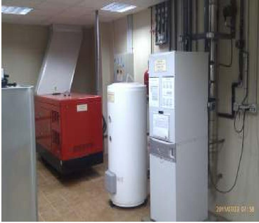
غرفة الأجهزة. مقدمة الصورة: سخان ومبادل حراري شمسي للمياه العذبة، ومدخنة، ومجس درجة الحرارة، وشبكة مواسير وصمامات. من الخلف (محبوب)، ألواح شمسية وأجهزة توزيع لتدفئة المسابح وخزانات التمدد البخاري. الخلفية: مولد كهربائي ثلاثي الأطوار (30 كيلو فار)، ونظام الإخلاء بسبب الأبخرة ولوحة التحكم التلقائي.
